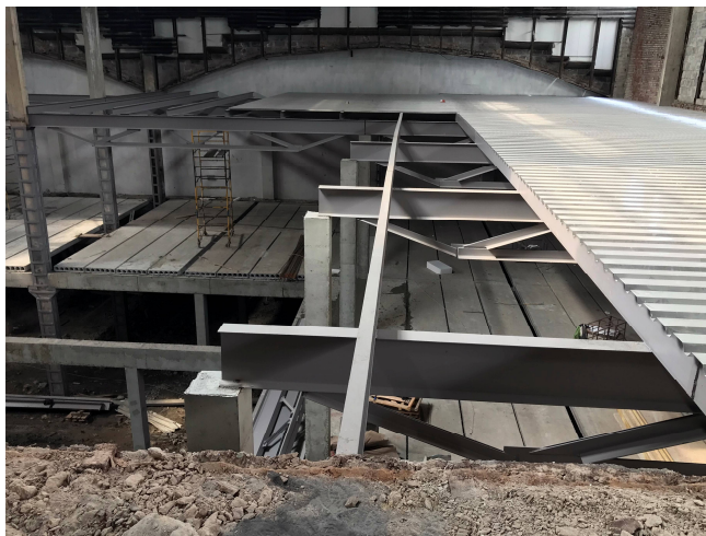
Рис. 5. Загальний вигляд цеху під час реконструкції
