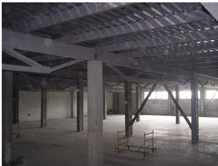
Рис. 6 Вигляд цеху після реконструкції
